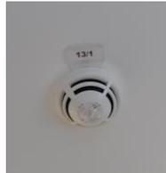
**Abb. 17:** beispielhaft automatischer Rauchmelder (nur in Bauteil A)
