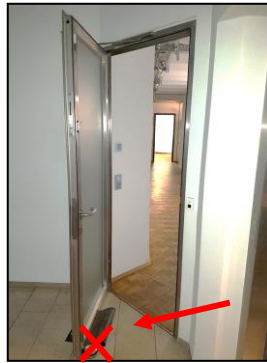
Abb. 6: unterkeilte Brandschutztür
